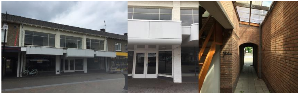
Weergave van de voorzijde van het plangebied (Stuijvenburchstraat 143) Bron: Bureau voor architectuur en bouwadvies B.v.
