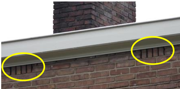
Potentiële invliegopeningen voor vleermuizen in het gebouw.
