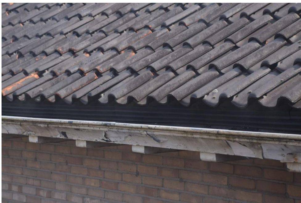
16 Combiprofiel onder de dakpannen bij de dakgoot.
