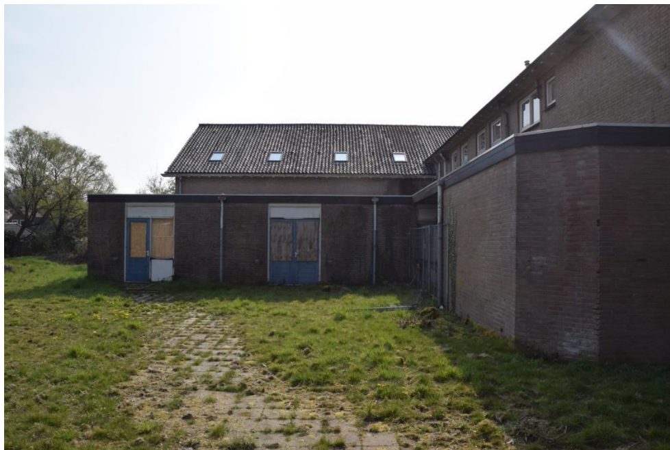
7 Lagere gedeelte van het schoolgebouw met boeidelen en daktrim.
