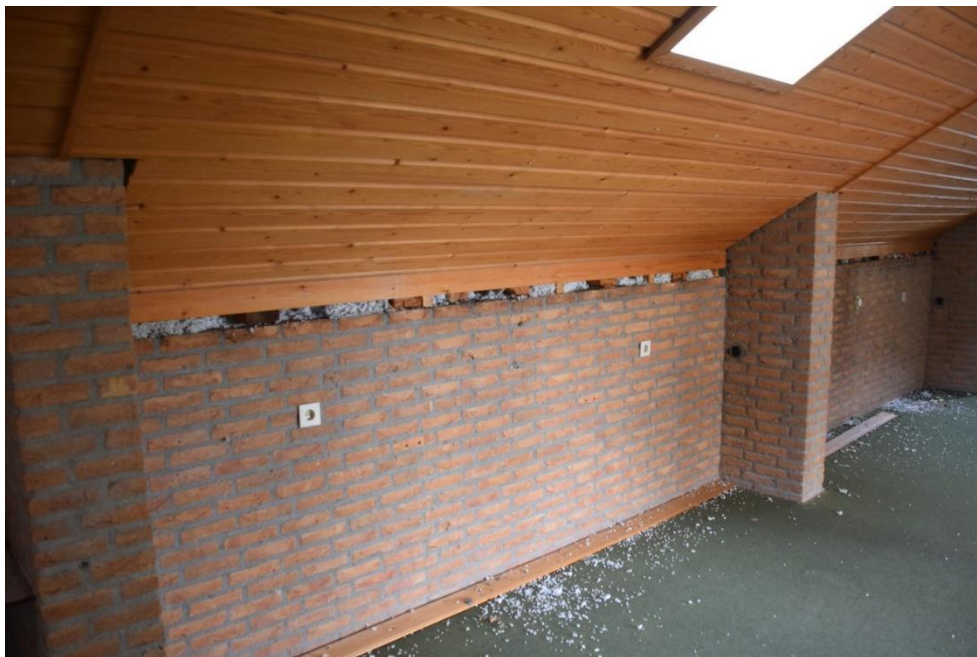
13 Gang op de eerste verdieping van het gebouw met een doorgang naar de ruimte onder het dak.
