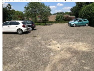
foto 6 - ter plaatse van boring PB02
