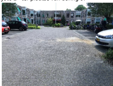
foto 5 - ter plaatse van boring PB01
