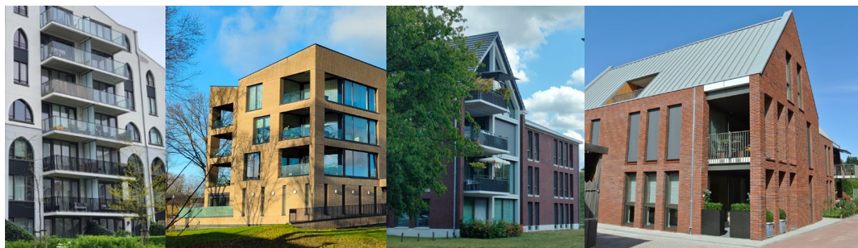
Afbeelding 17. Balkons / loggia's binnen bouwvolume
