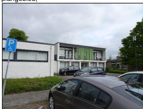
Aanzicht voorzijde leegstaand kantoor;
