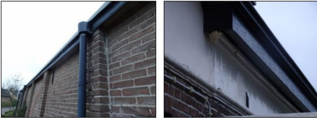
Figuur 1.9 (links): Geschikte opening achter de regenpijp; Figuur 1.10 (rechts): Geschikte openingen achter de boei delen.
