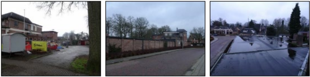
Figuur 1.2 (links): Noord en westzijde van het plangebied; Figuur 1.3 (midden): Zuidoostzijde van het plangebied; Figuur 1.4 (rechts): Platdak later aangebouwde deel.
