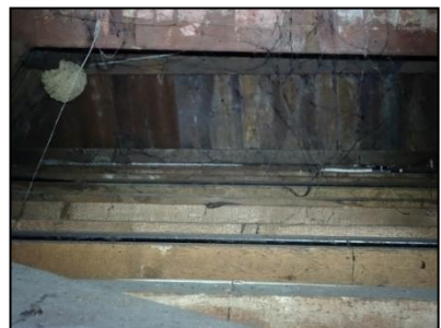
Figuur 8. Zolderruimte in de bebouwing.
