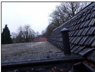
Figuur 6. Deel van het dak met schuine dakpan.
