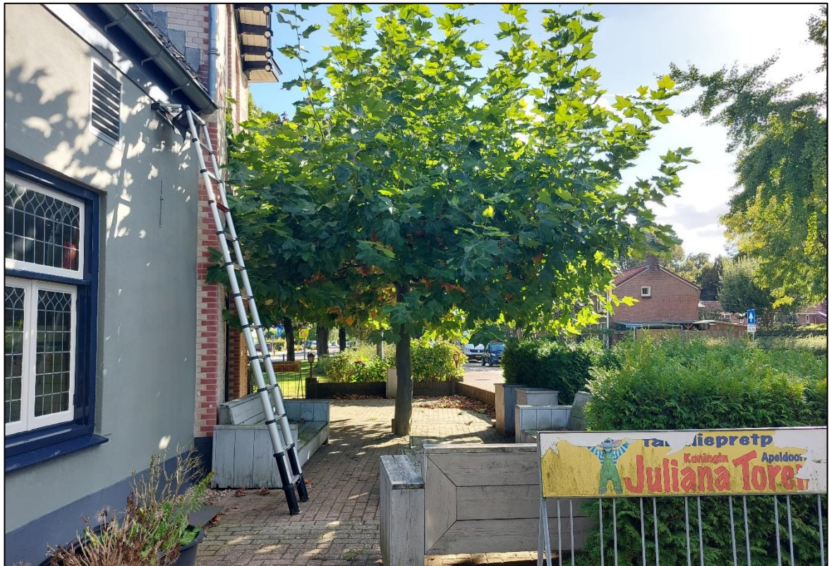
Figuur 1 De inspectie aan de westzijde van het te slopen pand.
