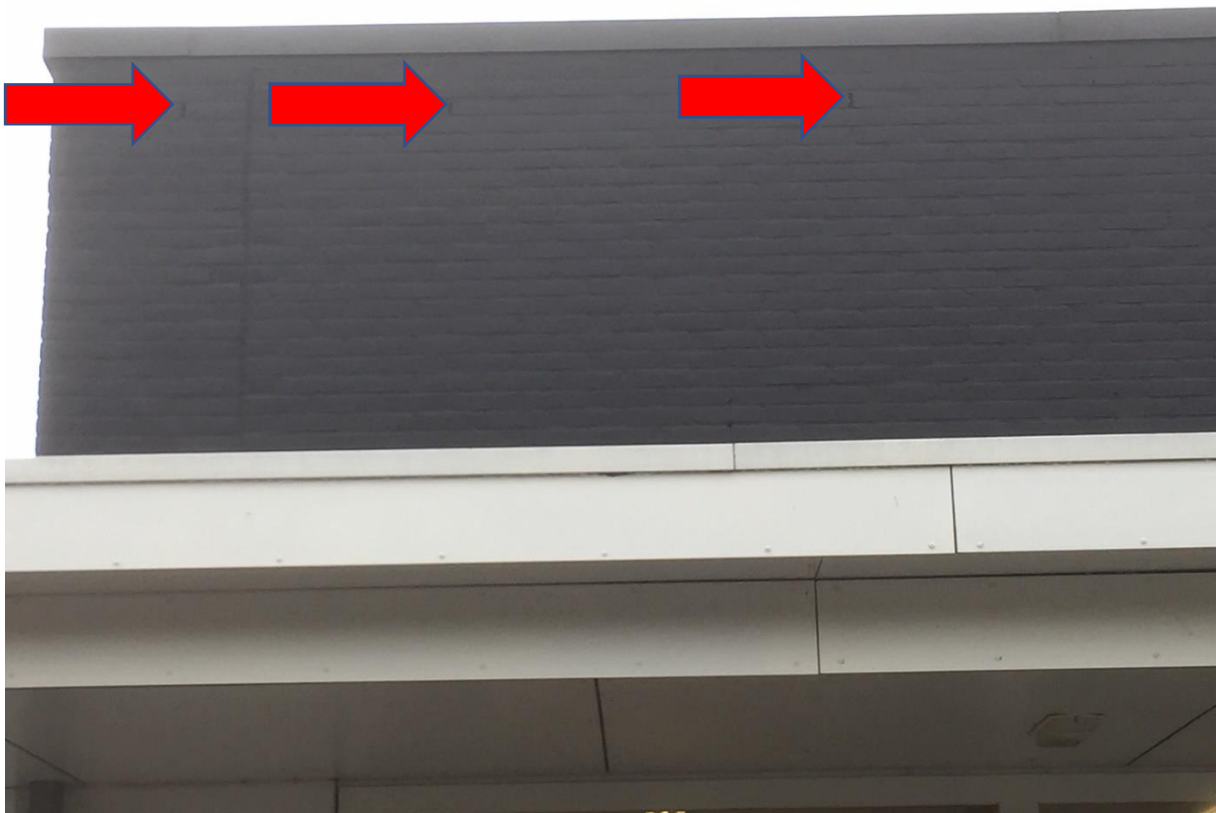
Figuur 3. Voorgevel. De rode pijlen wijzen naar drie van de open stootvoegen.
