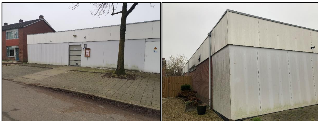
Figuur 2.9 (links): De noordzijde van het gebouw. Deze zijde is niet gemetseld; Figuur 2.10 (rechts): De oostzijde van het gebouw.
