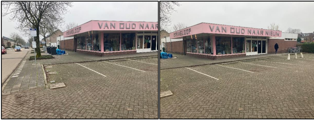
Figuur 2.3 (links): De westgevel; Figuur 2.4 (rechts): De zuidgevel, voor de zuidgevel bevindt zich de parkeerplaats.
