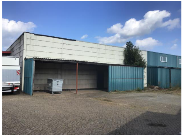
Fotonummer 2: Achterzijde onderzoekslocatie.
