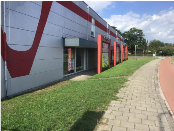
Fotonummer 1: Oostzijde onderzoekslocatie.
