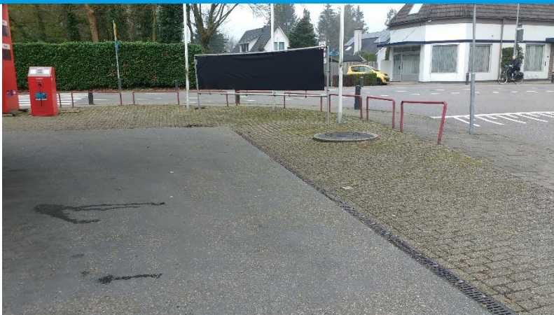
Obas en afvoer gem. riool
