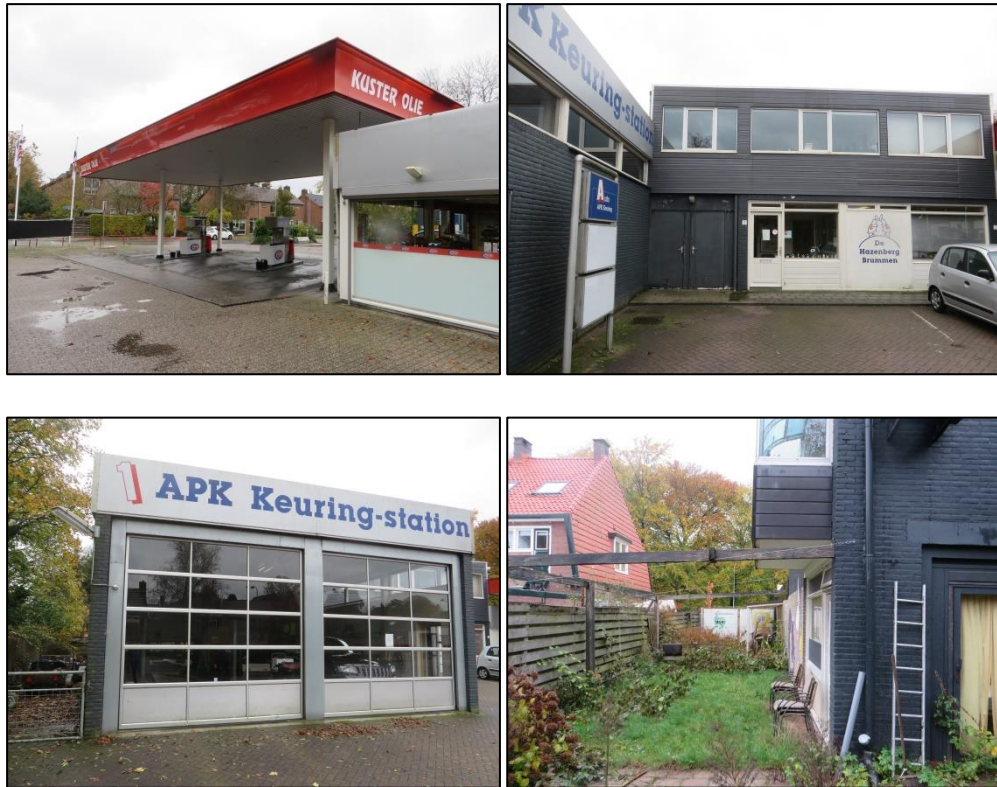
Huidige situatie in en rond het plangebied Zutphensestraat (7 november 2019).
