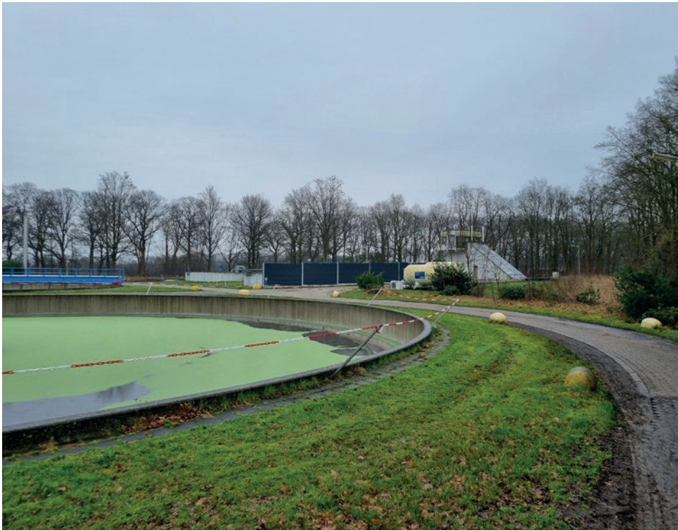
1 terrein met waterzuiveringsinstallatie
