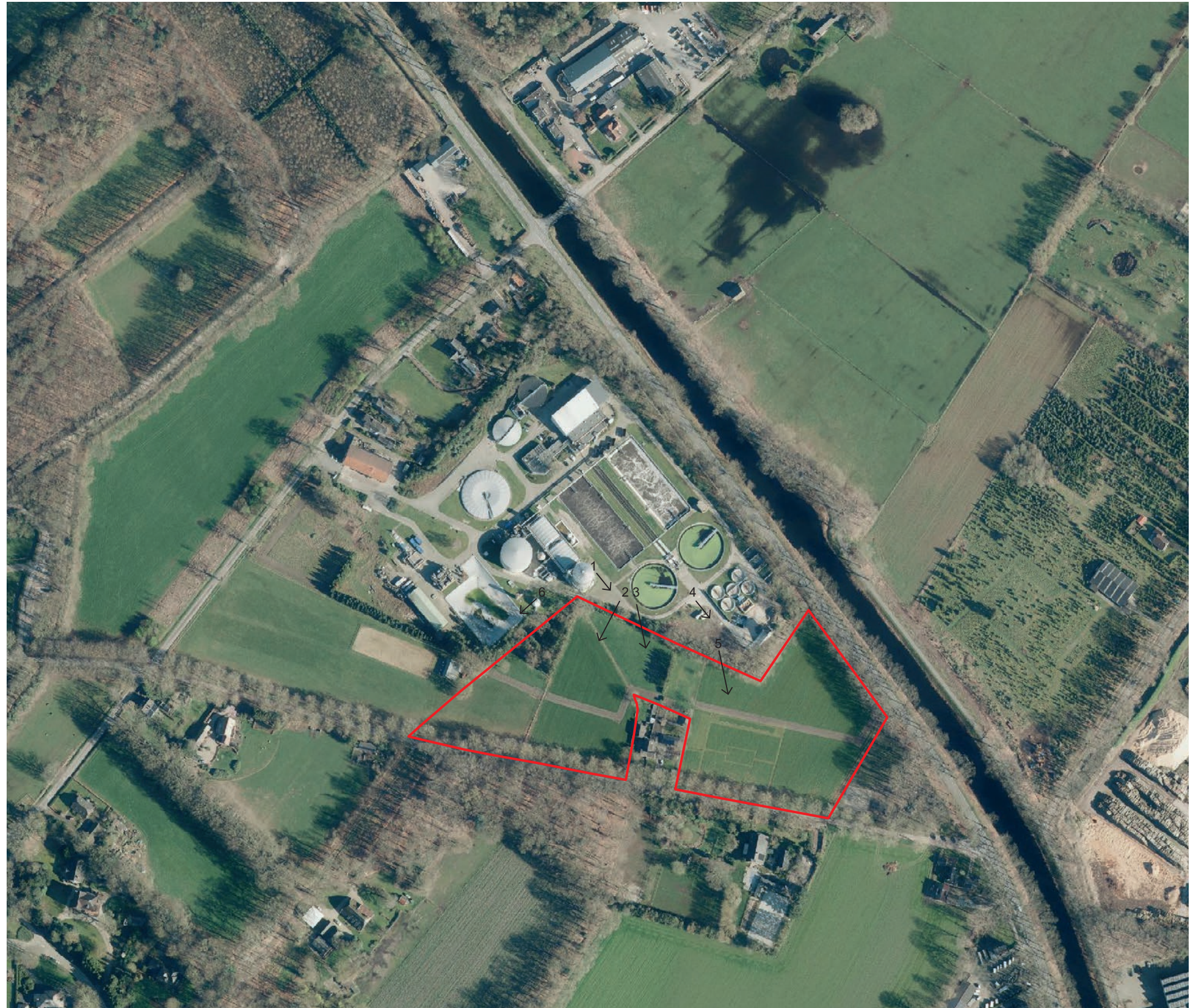
Luchtfoto met uitbreidingslocatie rood omlijnd.
