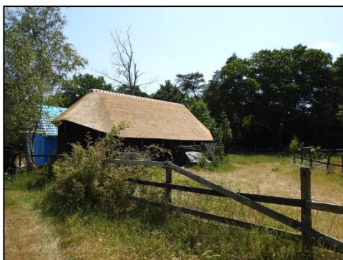
Paardenstal gezien vanaf de noordzijde
