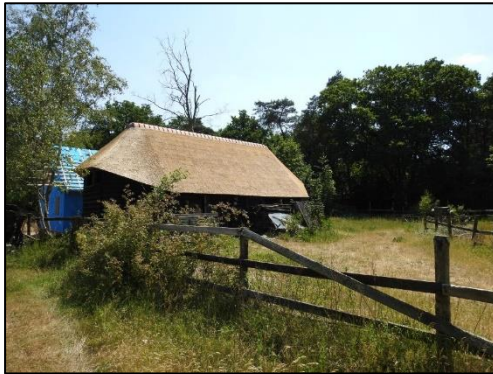
Paardenstal gezien vanaf de noordzijde
