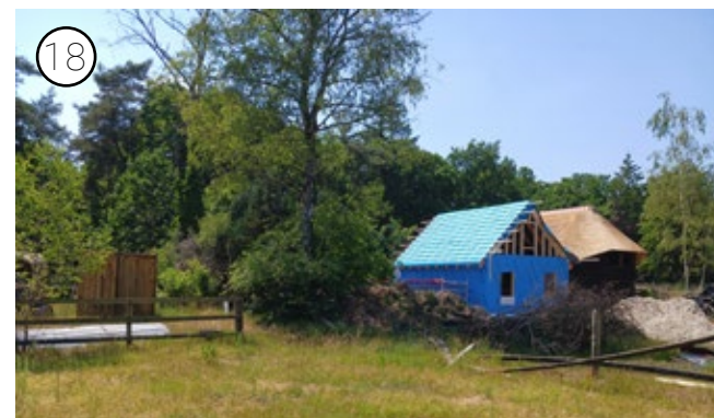
Zicht op de aanbouw
