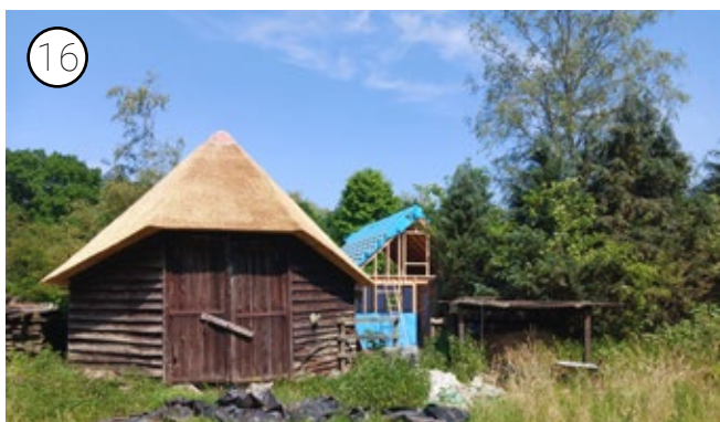
Zicht op de aanbouw
