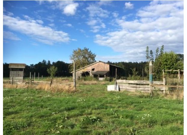
Figuur 5. Kapschuur (nr. 2).
