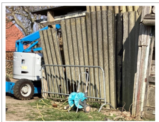
Bouwwerk met asbestverdachte golfplaten
