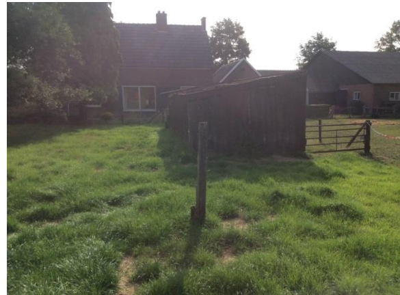
Figuur 4: Dak(goot) bebouwing
