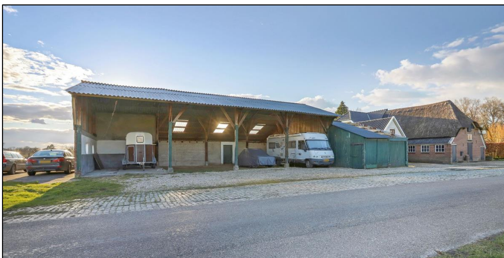
Plangebied vanuit zuidoostelijke richting vanaf de Sintelweg met de woning op de achtergrond en de aangrenzende opstallen op de voorgrond (bron: Funda)
