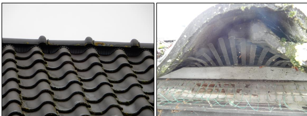
Figuur 7 Fotografische indruk van het vogelwerend materiaal dat bevestigd is aan het dak van de bedrijfswoning.
