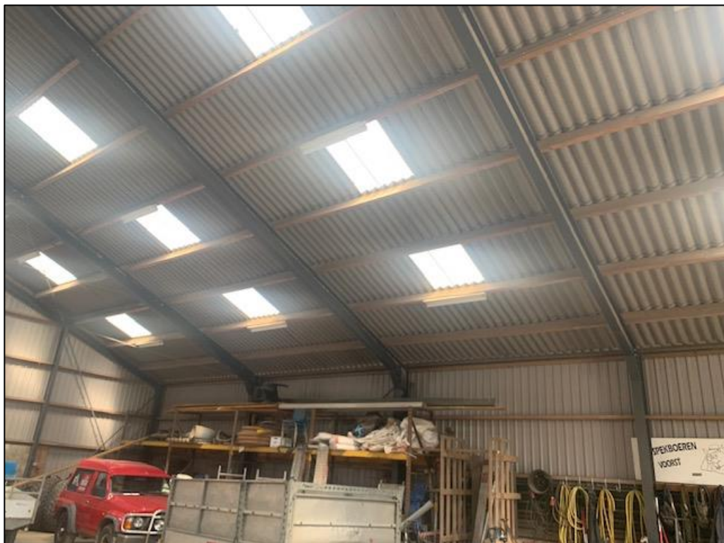
Figuur 6 Binnenzijde van de loods welke uitgebreid zal worden (loods 1).
