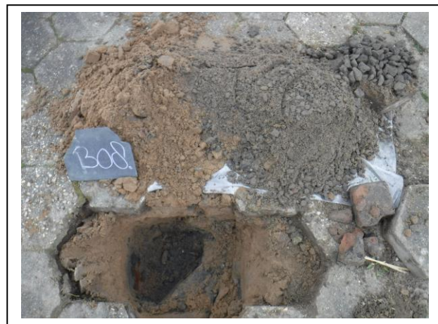
Foto: Inspectiegat B08
