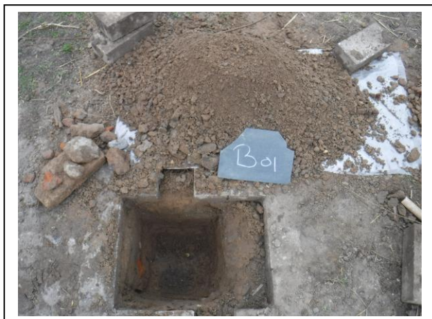
Foto: Inspectiegat B01
