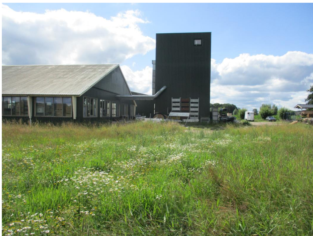
Figuur 2 Eén van de loodsen en een deel van de grasweide.
