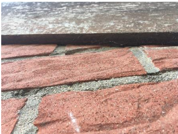
De windveer is strak tegen de buitengevel bevestigd waardoor vleermuizen geen verblijfplaats kunnen bezetten achter de windveer.
