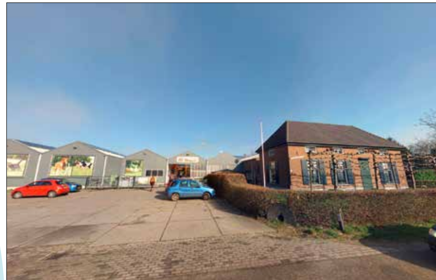
de bestaande bedrijfswoning
