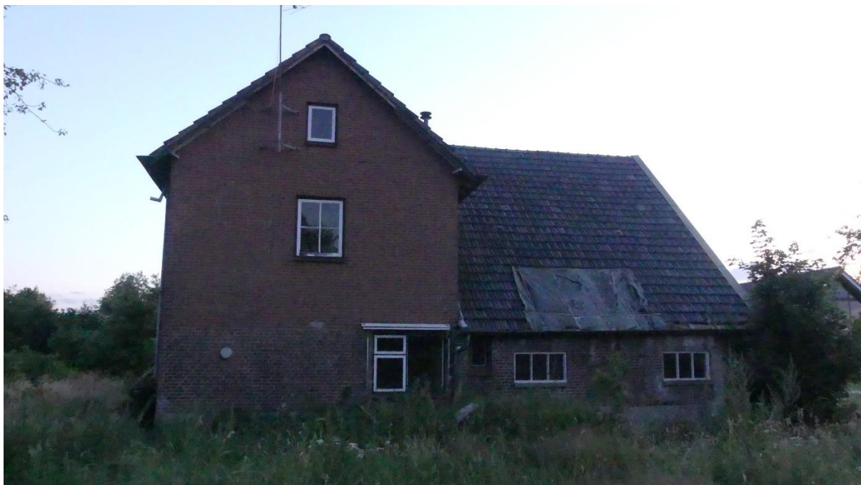
Figuur 2. Te slopen boerderij met schuur
