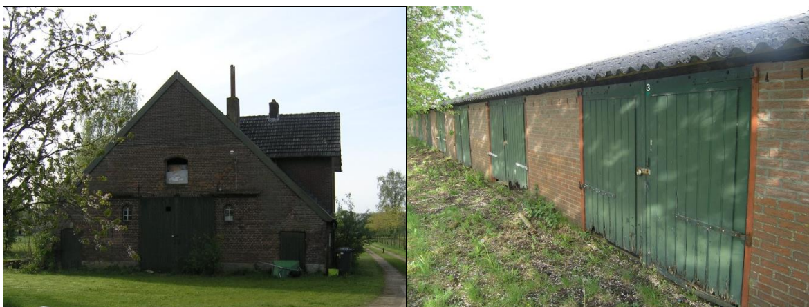
De te slopen bebouwing met links de woning en rechts de schuur (27 april 2018).
