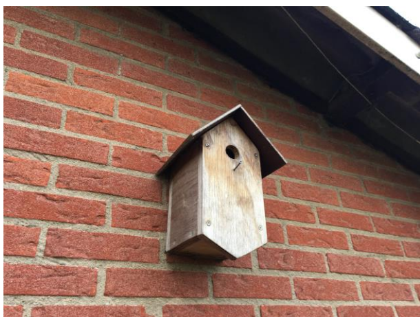
Vogelkastje aan de muur van de te slopen stal in deelgebied Elzenbosweg.
