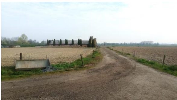
Foto 1: Puinpad met zicht op toekomstig bouwvlak en achter de stal met druppelzones aan de Weg door de Plas 10.
