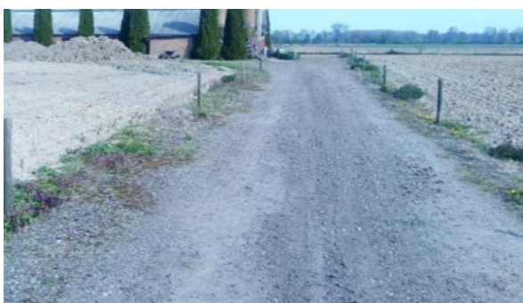
Foto 3: Puinpad aan de Weg door de Plas 10, opgebouwd uit een toplaag van asfaltgranulaat met daaronder repac, puin en bakstenen.
