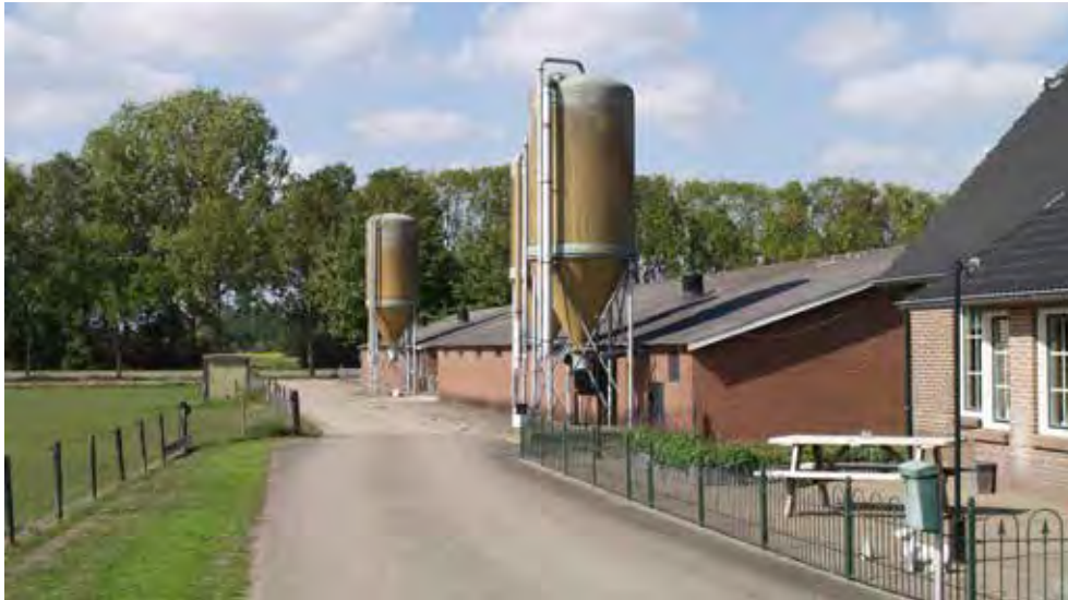
Afbeelding: Te slopen stallen
