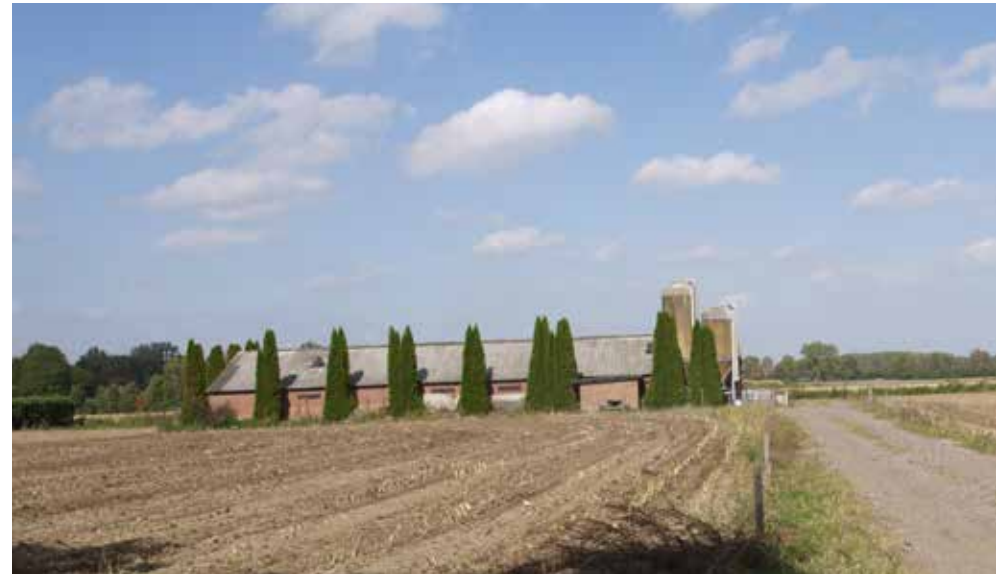
Afbeelding: Te slopen stal
