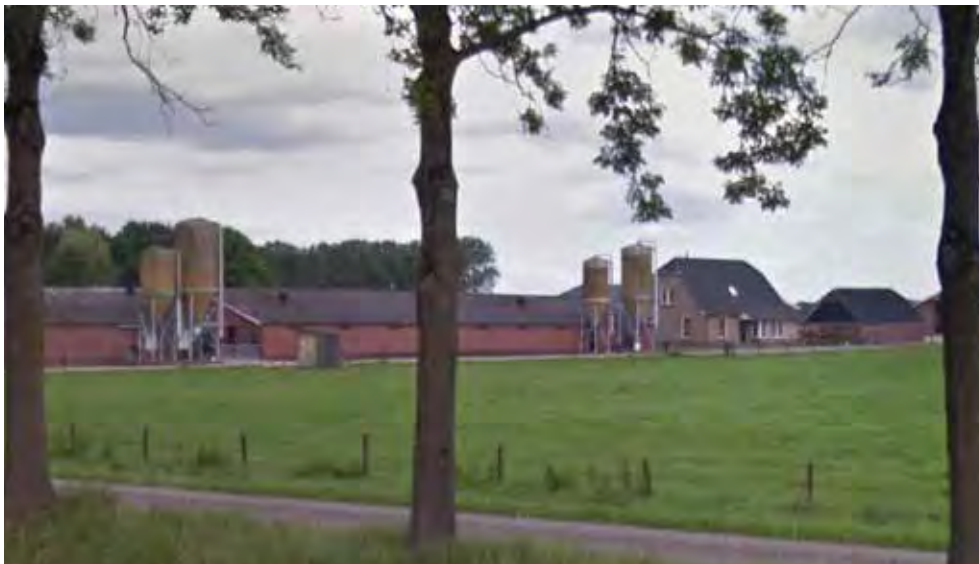
Afbeelding: Te slopen stallen en te behouden woning
