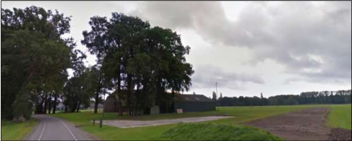
Figuur 2.5 Aanzicht westzijde plangebied vanaf Hoevesteeg
