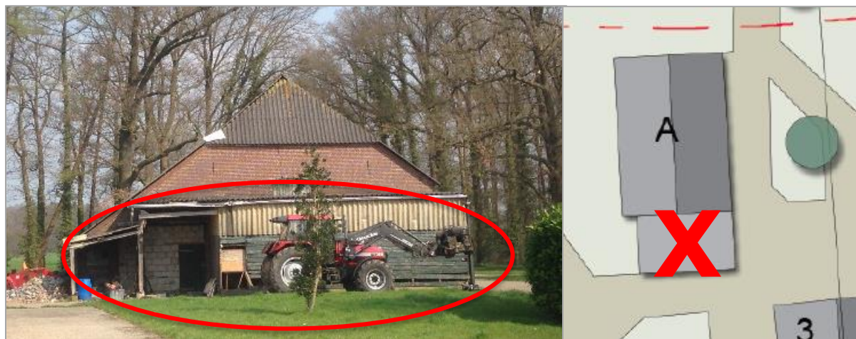
Figuur 3: Weergave te slopen schuur.
