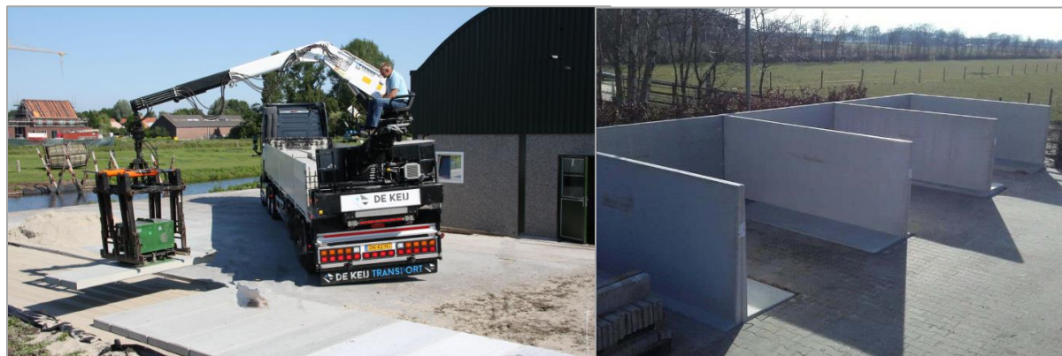
Figuur 2: Activiteit 1, links de vrachtwagen met prefab-betonelementen en rechts de opslagvakken.
