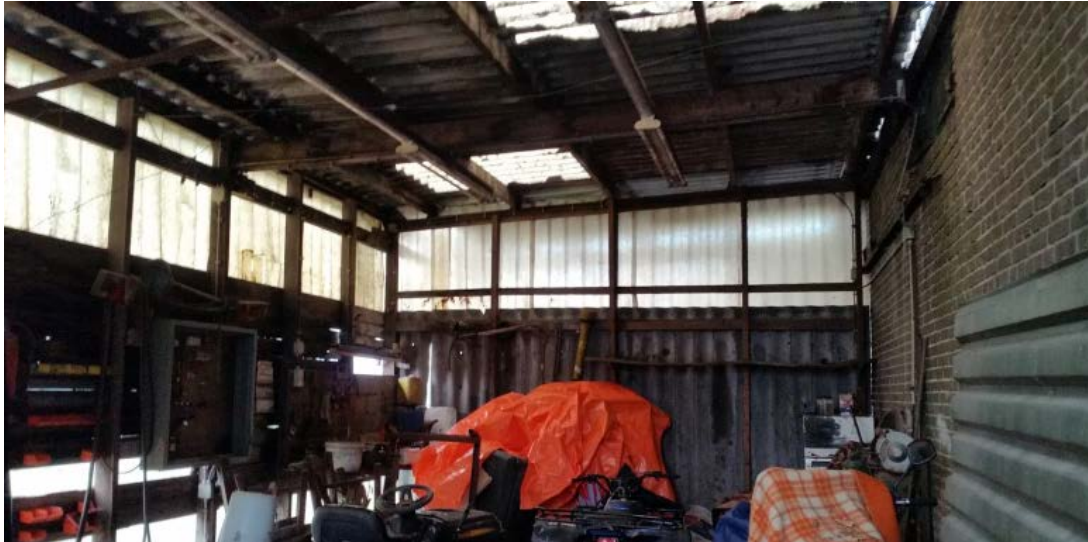
Binnenzijde van de te slopen aanbouw
