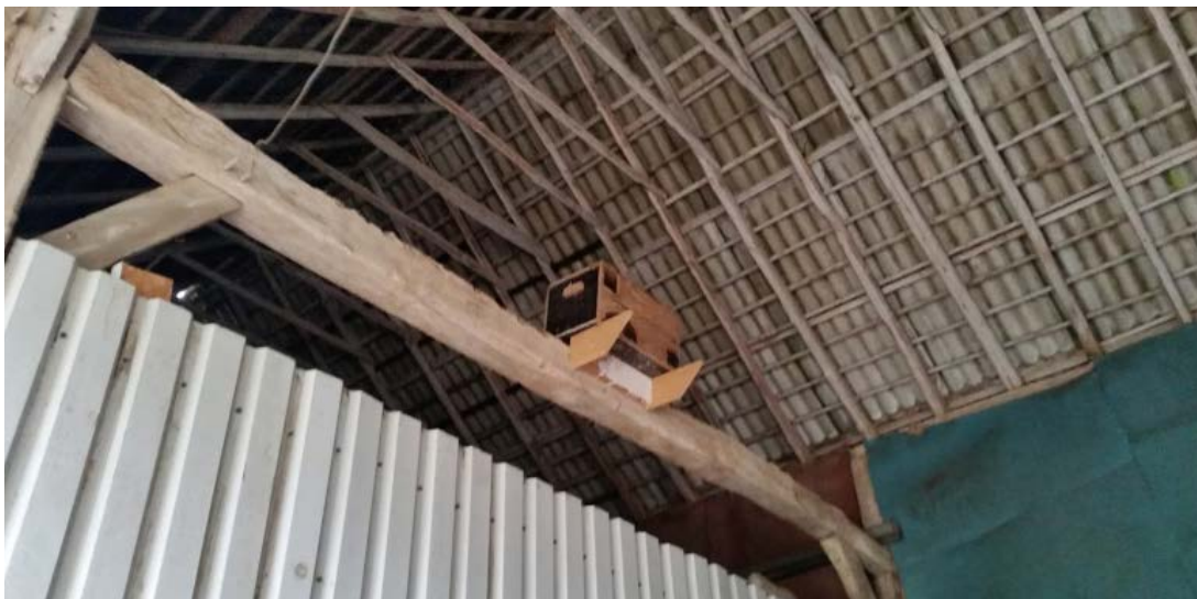
Te slopen schuur
