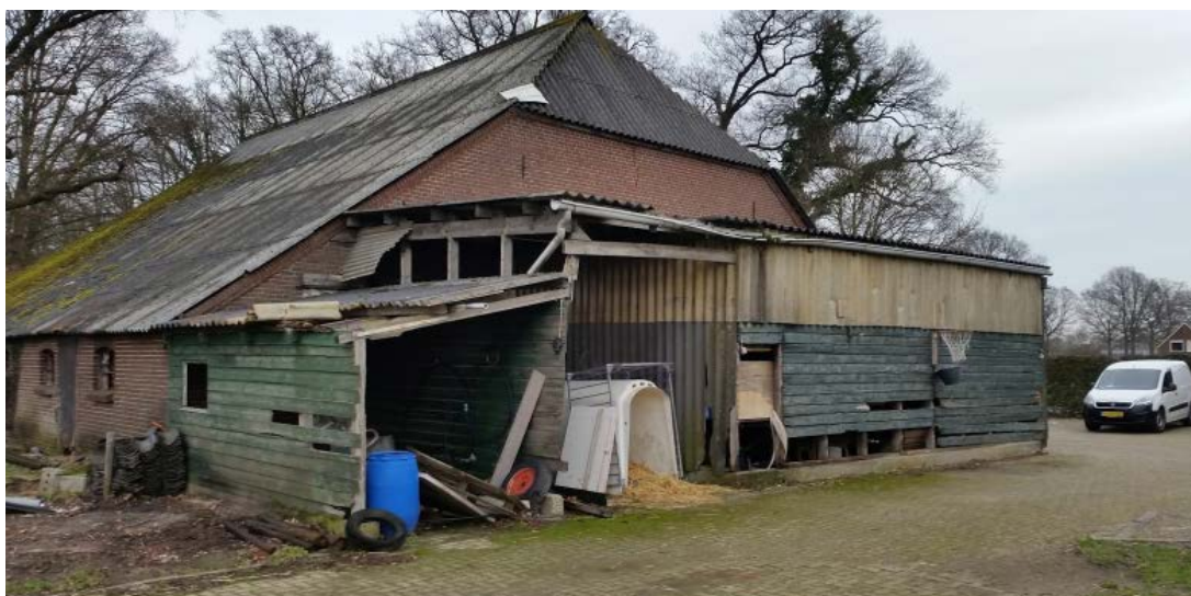
Te slopen schuur
