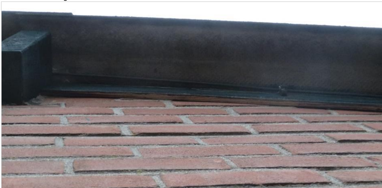
Afbeelding 5.1: Nauw aansluitende gevelbetimmering van de ligboxenstal. Foto: Natuurkompas, 2019.
