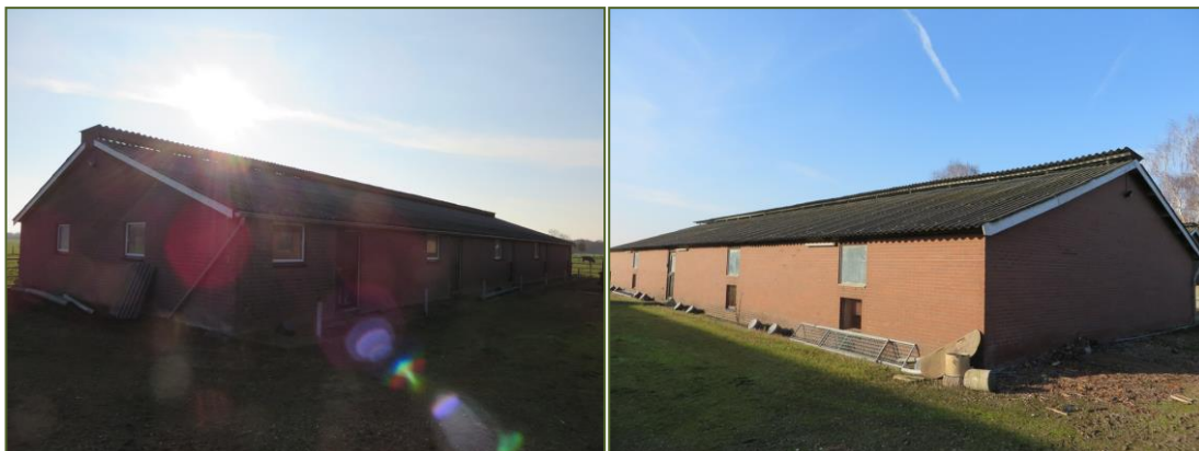
Foto's: Indruk van de te amoveren varkenstallen.
