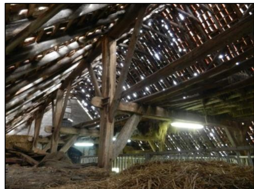
Figuur 12: Binnenzijde veeschuur.
