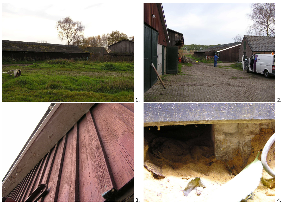
Foto 1 en 2: overzicht te slopen gebouwen
