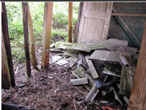
Foto b6.5 Asbestmateriaal op maaiveld
