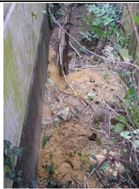
Foto b6.4 Asbest op maaiveld, boring ernaast
