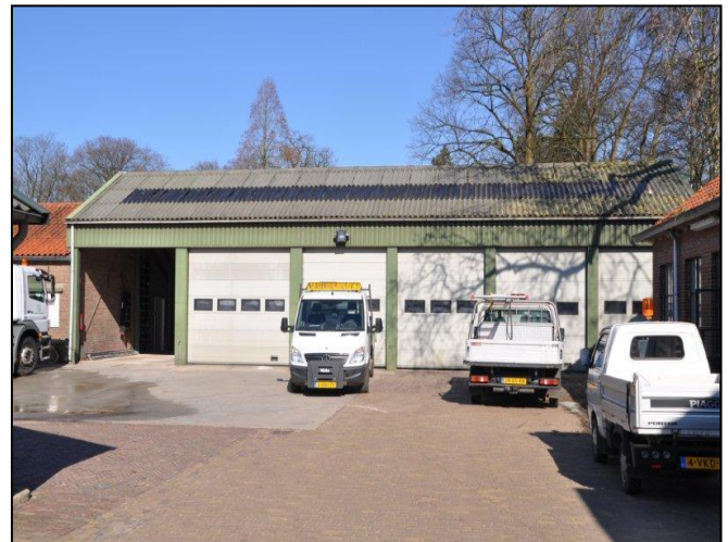
De te verplaatsen loods
