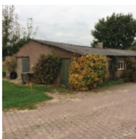
te slopen schuur
