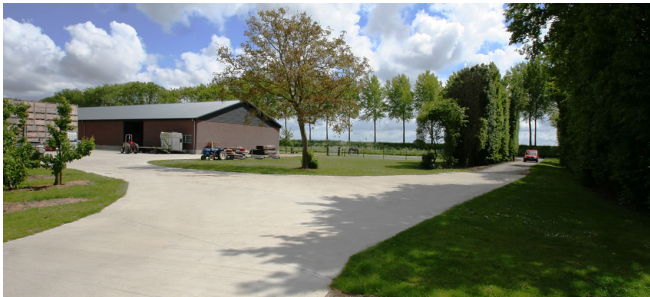
gezamenlijk nieuw erf gietbeton
