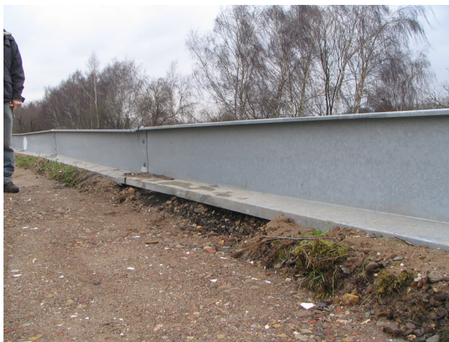
Figuur 6. Robuust aluminium scherm met overstekende rand
