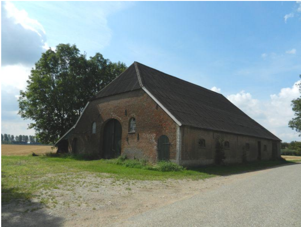
Foto 1. Buitenzijde monumentale schuur.
