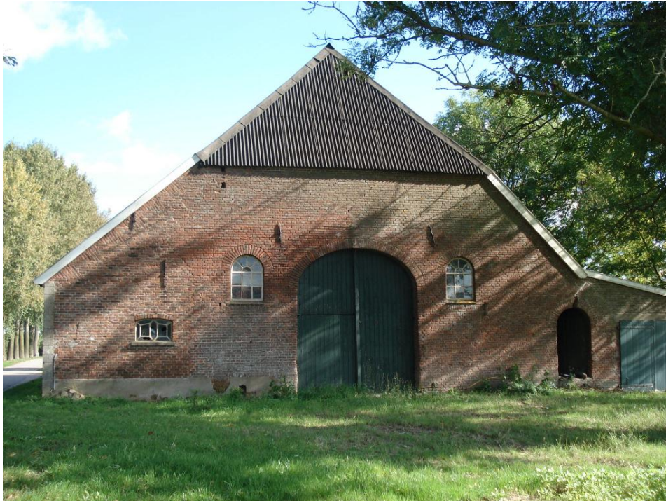
Schuur, gezien vanuit het zuidwesten
