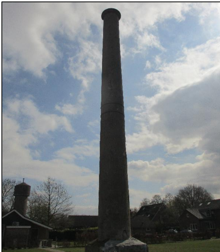
Figuur 2 De schoorsteen ten noorden van de planlocatie.
