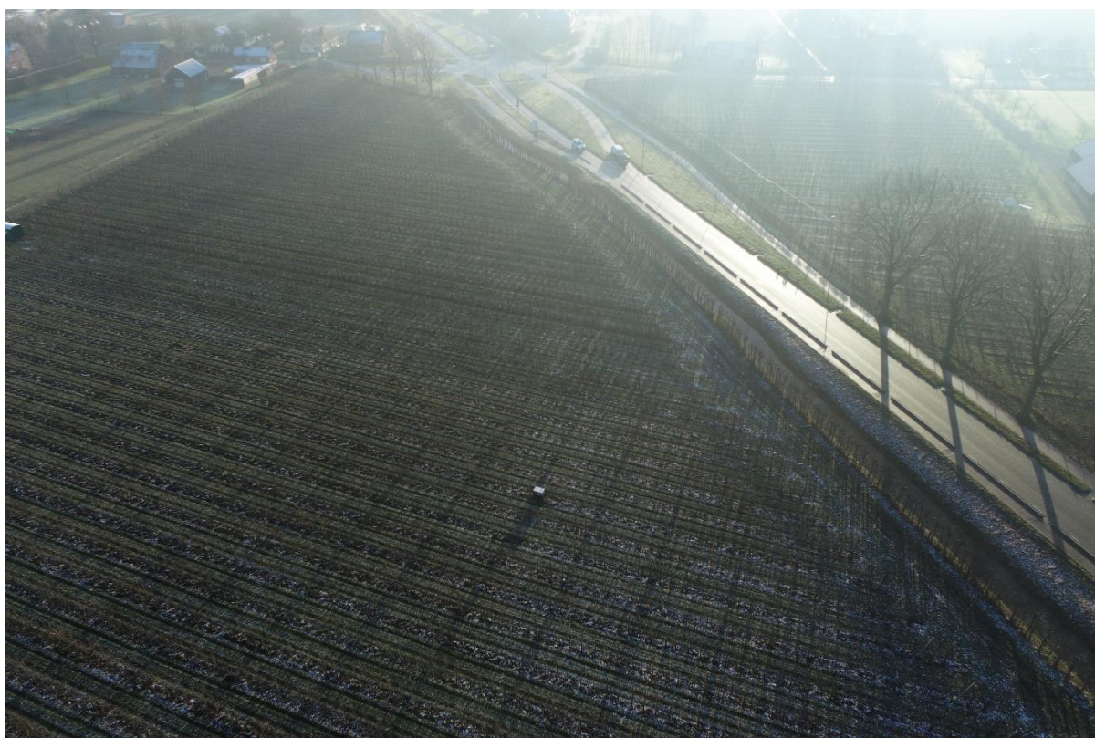
Foto genomen richting het oosten (van Heemstraweg)
